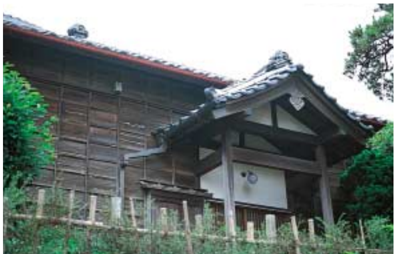
図1 千葉市ゆかりの家・いなげ(愛新覺羅溥儀飯寓) 撮影のため警報装置などを隠しています。
